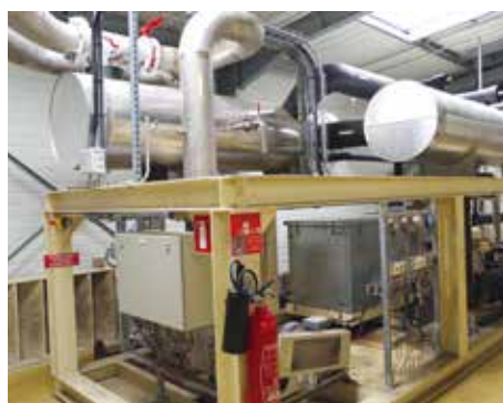
Réservoirs d'azote pour la partie séchage.
