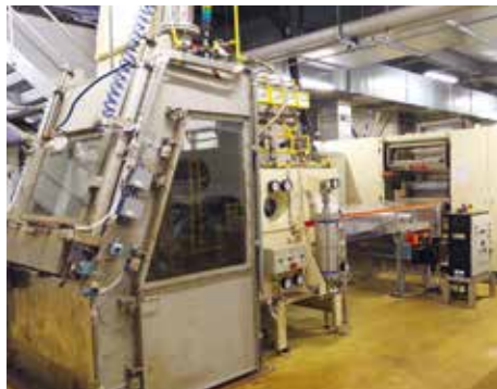
Un module partie basse de « E9 ».
